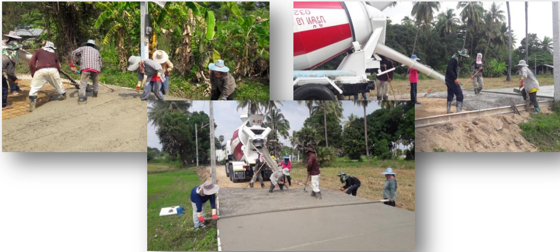
โครงการก่อสร้างถนน คสล. หมู่ที่ 5 (ซอย 2 ต่อจากเดิม)
