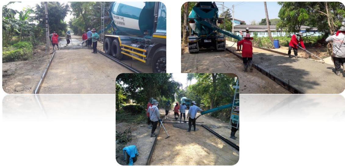
โครงการก่อสร้างถนน คสล. หมู่ที่ 4 (จากโรงเรียนบ้านช่อง-เขตรถไฟ)
