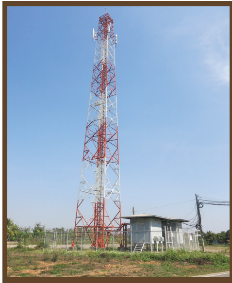
รูปที่ 5 หอคอยสำหรับรองรับการติดตั้งสายอากาศของสถานีฐานระบบโทรศัพท์เคลื่อนที่
